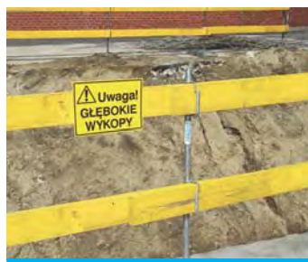
Zabezpieczenie krawędzi wykopu.
