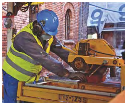
Przy mechanicznym cięciu należy zakładać maskę ochronną, ochronniki słuchu i okulary ochronne.
