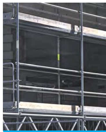
Balustrady ochronne od szczytu rusztowania.
