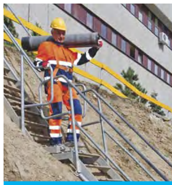
Bezpieczne zejście do wykopu.
