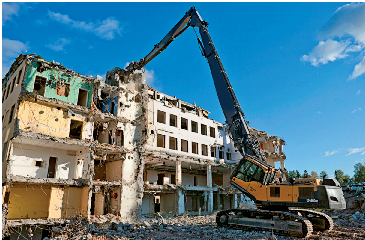
Rozbiórka budynku murowanego za pomocą koparki.
