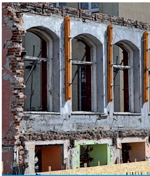
Sposoby zabezpieczenia starych ścian przed przewróceniem.
