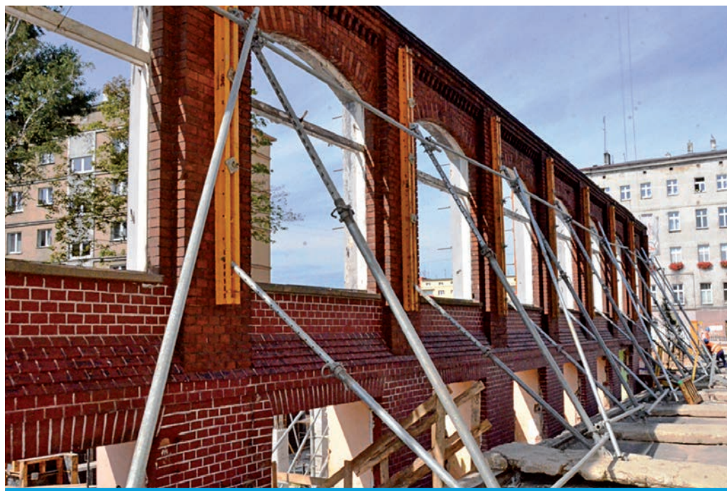
Sposoby zabezpieczenia starych ścian przed przewróceniem.
