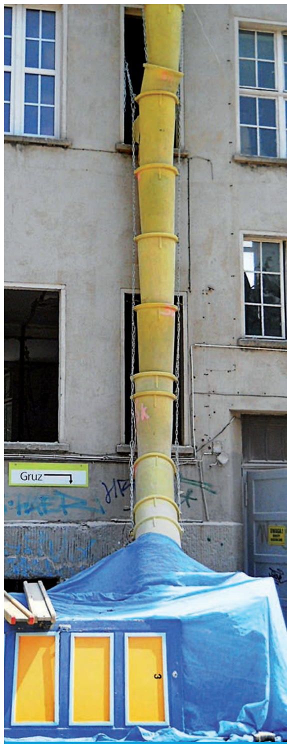
Rynna zsypowa do gruzu eliminuje ręczne znoszenie materiału z rozbiórki.
