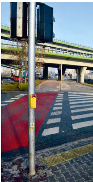
Rys. 2-27. Wyposażenie sygnalizatora świetlnego na przejściu dla pieszych w przycisk umożliwiający generowanie sygnału akustycznego (źródło: CIOP-PIB)
