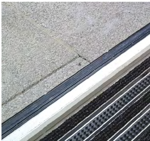
Rys. 2-20. Prawidłowo wykonany próg drzwi wejściowych (źródło: CIOP-PIB)
