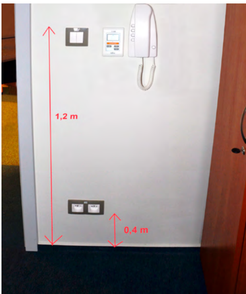
Rys. 2-49. Przykład prawidłowo umieszczonych gniazd wtyczkowych i włącznika oświetlenia (źródło: CIOP-PIB)
