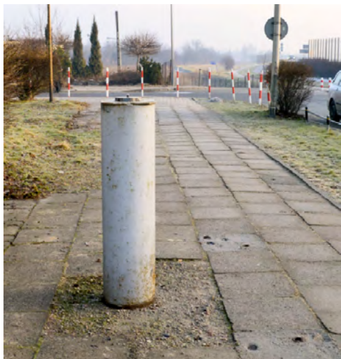
Rys. 2-32. Przykład bariery – wystający z chodnika stalowy element ograniczający przejście (źródło: CIOP-PIB)
