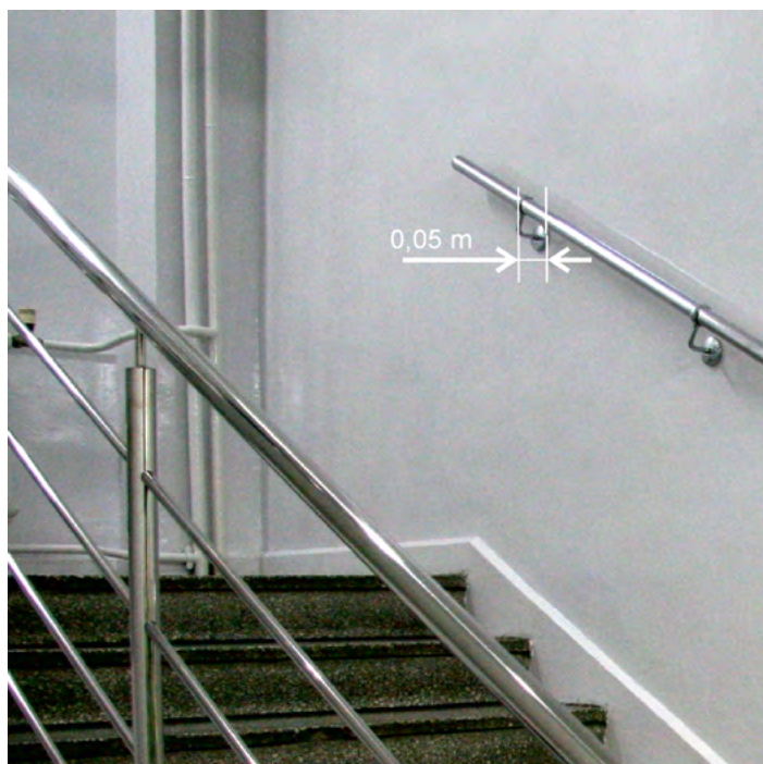
Rys. 2-15. Przykład poprawnego mocowania poręczy przyściennej (źródło: CIOP-PIB)
