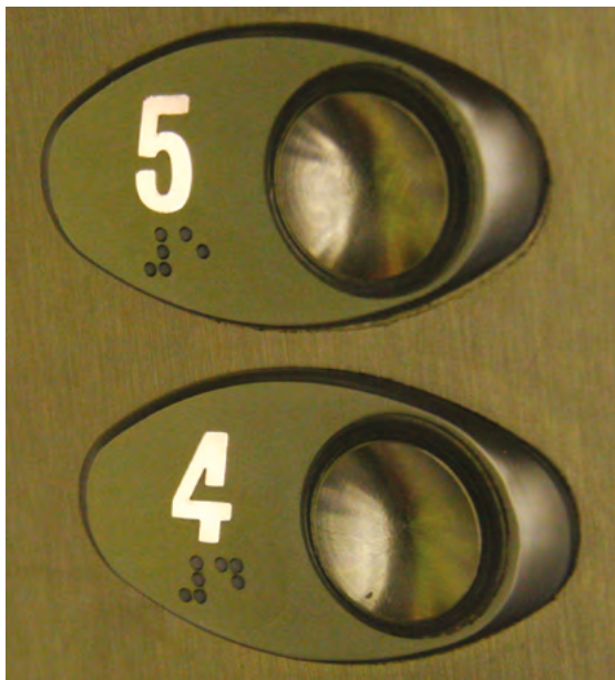
Rys. 3-23. Przykład przycisków na tablicy przyzywowej w kabinie dźwigu osobowego dodatkowo oznakowanych za pomocą alfabetu Braille'a (źródło: CIOP-PIB)
