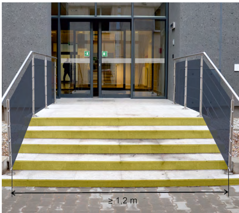
Rys. 2-8. Przykład prawidłowego rozwiązania schodów zewnętrznych (źródło: CIOP-PIB)
