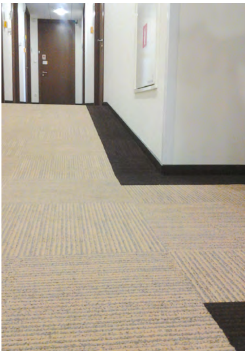
Rys. 2-53. Bordery wykonane w wykładzinie podłogowej (źródło: CIOP-PIB)
