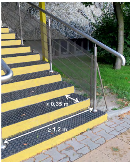
Rys. 2-9. Przykład prawidłowego zastosowania balustrady pośredniej na schodach zewnętrznych (źródło: CIOP-PIB)
