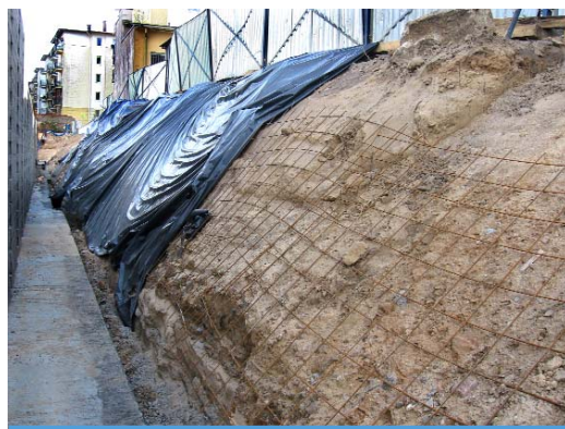
Fot. 16. Etapy wykonania zabezpieczenia skarpy poprzez ułożenie zbrojenia i w następnej kolejności mieszanki betonowej.
