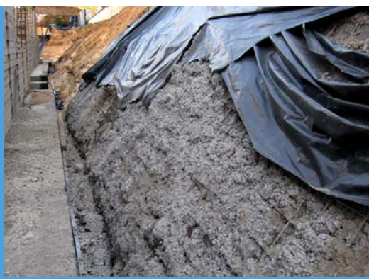
Fot. 17. Dodatkowym zabezpieczeniem przed rozmyciem skarpy i masy betonowej jest folia. Stosuje się ją do czasu utwardzenia się betonu.
