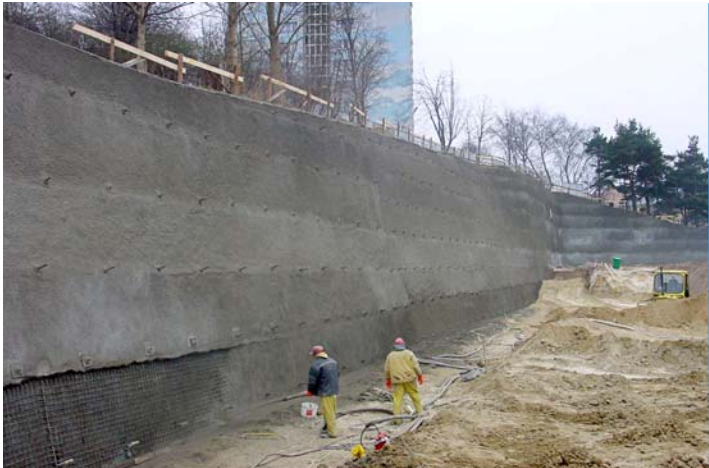
Fot. 19. Projekt gwoździowania powinien być tak wykonany, żeby nie utrudniał prowadzenia przyszłych prac budowlanych na sąsiedniej działce (terenie zagwoździowanym).
