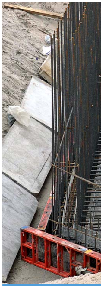
Fot. 15. Zabezpieczenie skarpy w poziomie posadowienia obiektu, płytami drogowymi typu „MON”. Płyty ułożono w celu ustabilizowania skarpy w miejscu, gdzie występuje największe ryzyko obsunięcia.
