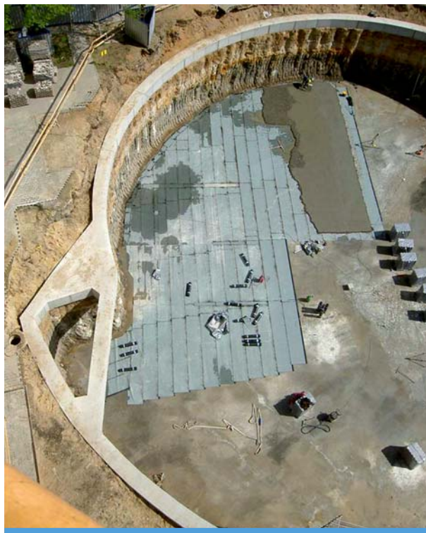
Fot. 22. Zdjęcie przedstawia palisadę z kolumn DSM usztywnioną oczepem żelbetowym.
