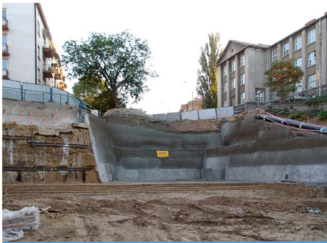
Fot.1. Roboty ziemne prowadzone w ścisłej zabudowie miejskiej. Przygotowanie robót w takim terenie wymaga szczegółowej analizy dokumentacji archiwalnej oraz monitoringu oddziaływania robót na stan przyległych do placu budowy obiektów.
