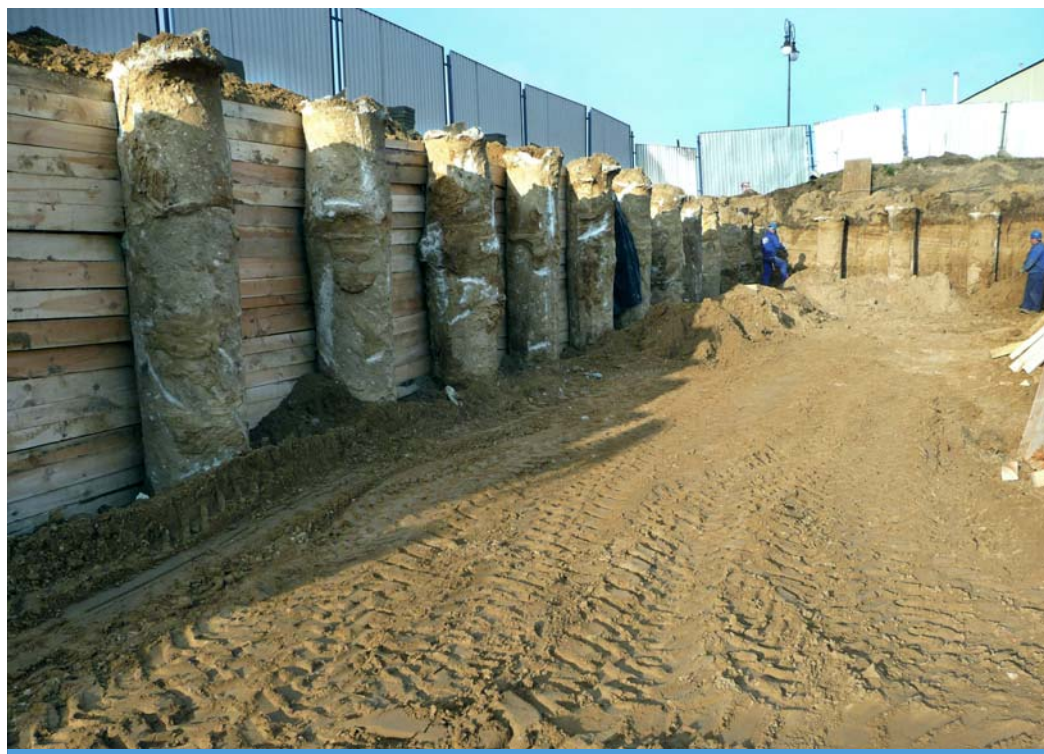
Fot. 21. Zabezpieczenie wykopu wykonane ścianką berlińską, gdzie elementem konstrukcyjnym są pale CFA. Ze względu na większą sztywność kolumn zabezpieczenie nie wymaga dodatkowego usztywnienia rozporami.
