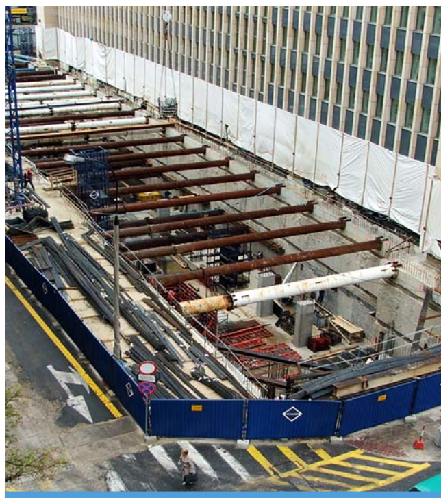
Fot. 28. Zabezpieczenia głębszych wykopów.
