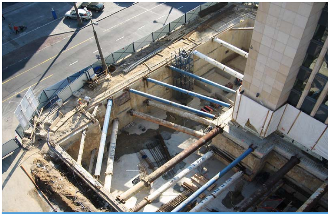
Fot. 26. Rozparcie ścian szczelinowych w narożniku wykopu w sąsiedztwie istniejącego budynku.
