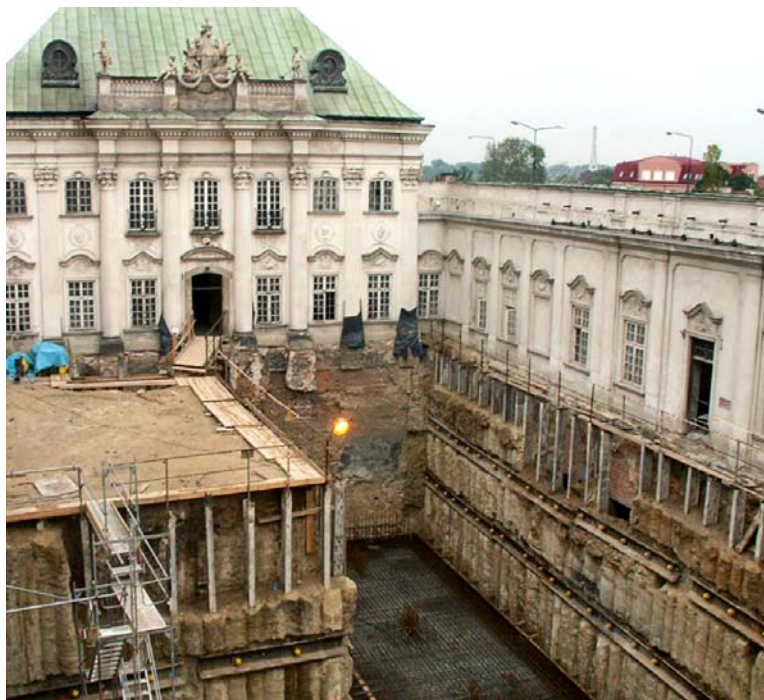
Fot. 22. Zdjęcie przedstawia palisadę z kolumn DSM usztywnioną oczepem żelbetowym.
