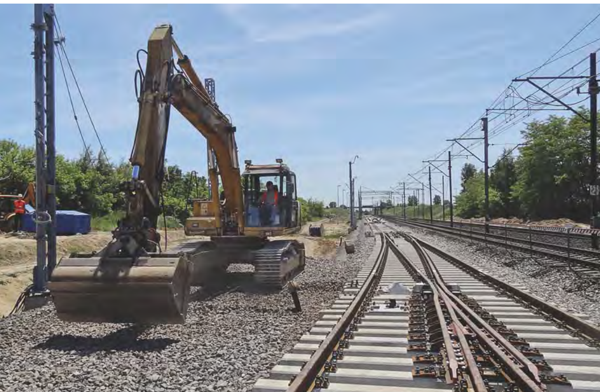
Fot. 33. Ładowarka gąsiennicowa
