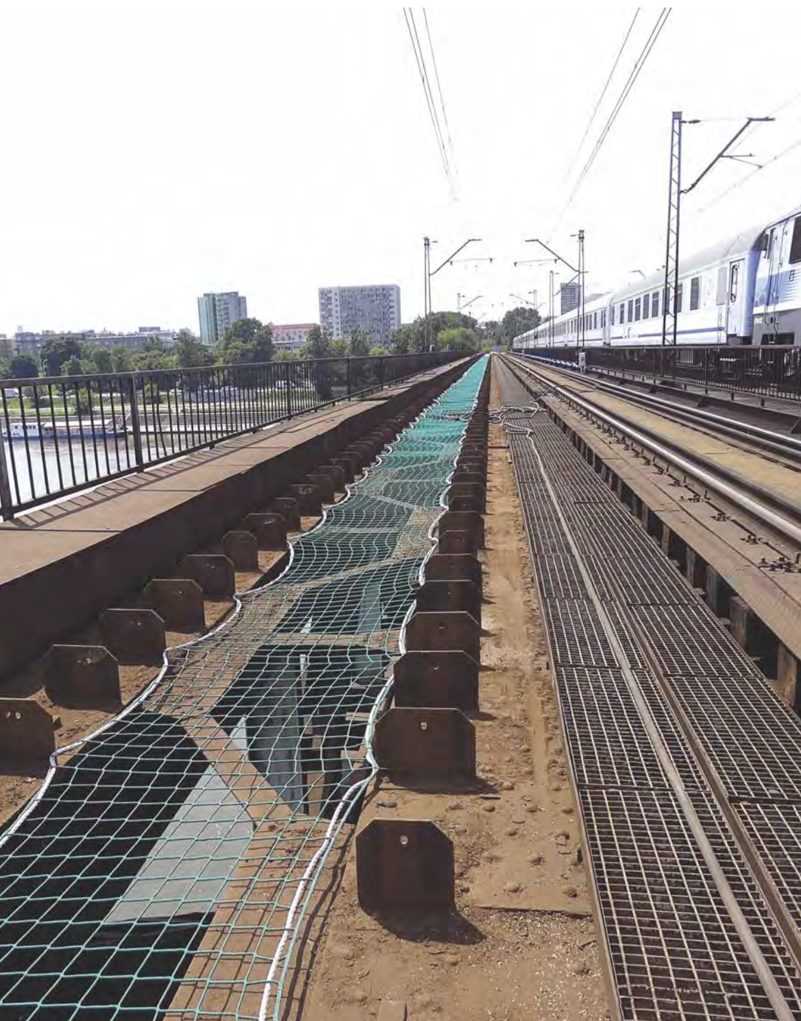
Fot. 30. Siatka bezpieczeństwa zastosowana podczas remontu drogi kolejowej na moście średnicowym w Warszawie
