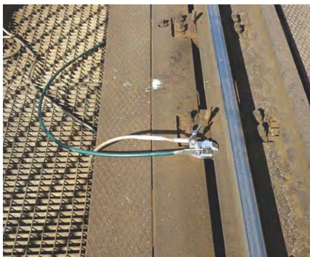
Fot. 29. Zacisk uszynienia, przenośnego uszyniacza ochronnego, przykręcony do szyny
