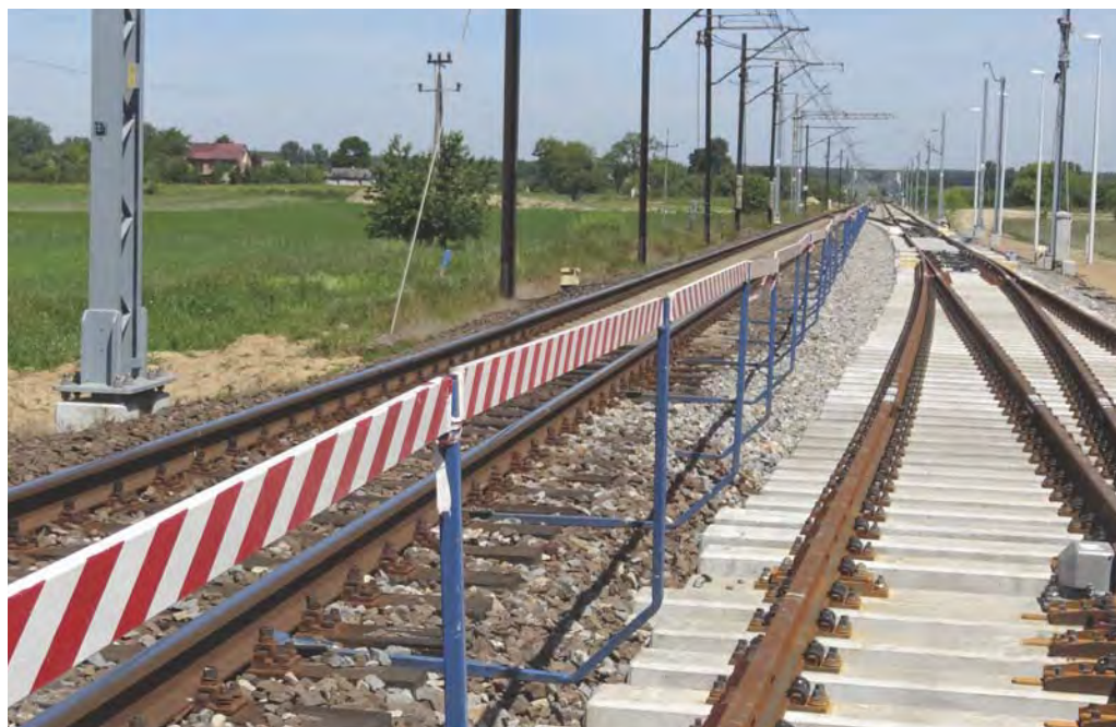
Fot. 16. Wygrodzenie międzytorza na stacji Strzałki, podczas przebudowy, w ramach zadania „Modernizacja linii kolejowej nr 4” (Centralna Magistrala Kolejowa)
