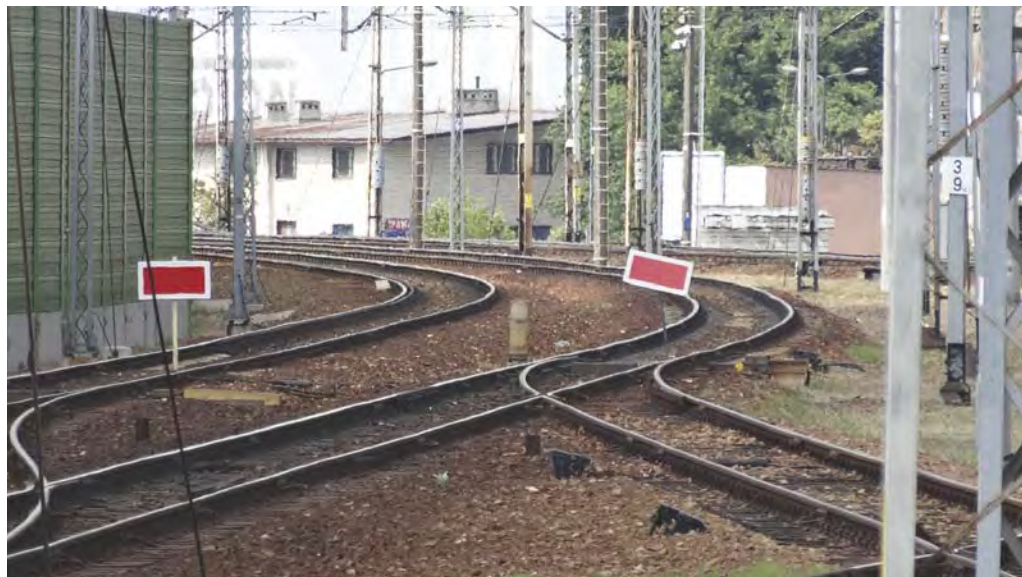
Fot. 14. Sygnał D1 „Stój” dawany tarczą zatrzymania na terenie stacji Warszawa Wschodnia Osobowa. Prostokątna czerwona tarcza z białą obwódką
