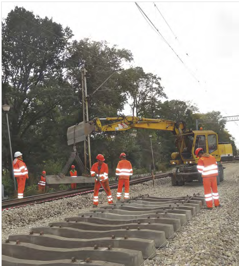
Fot. 36. Układanie podkładów za pomocą maszyny dwudrogowej
