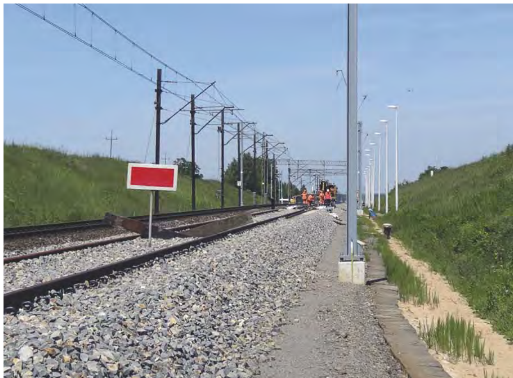
Fot. 15. Sygnał D 1 „Stój” dawany tarczą zatrzymania na terenie stacji Strzałki. Prostokątna tarcza czerwona z białą obwódką
