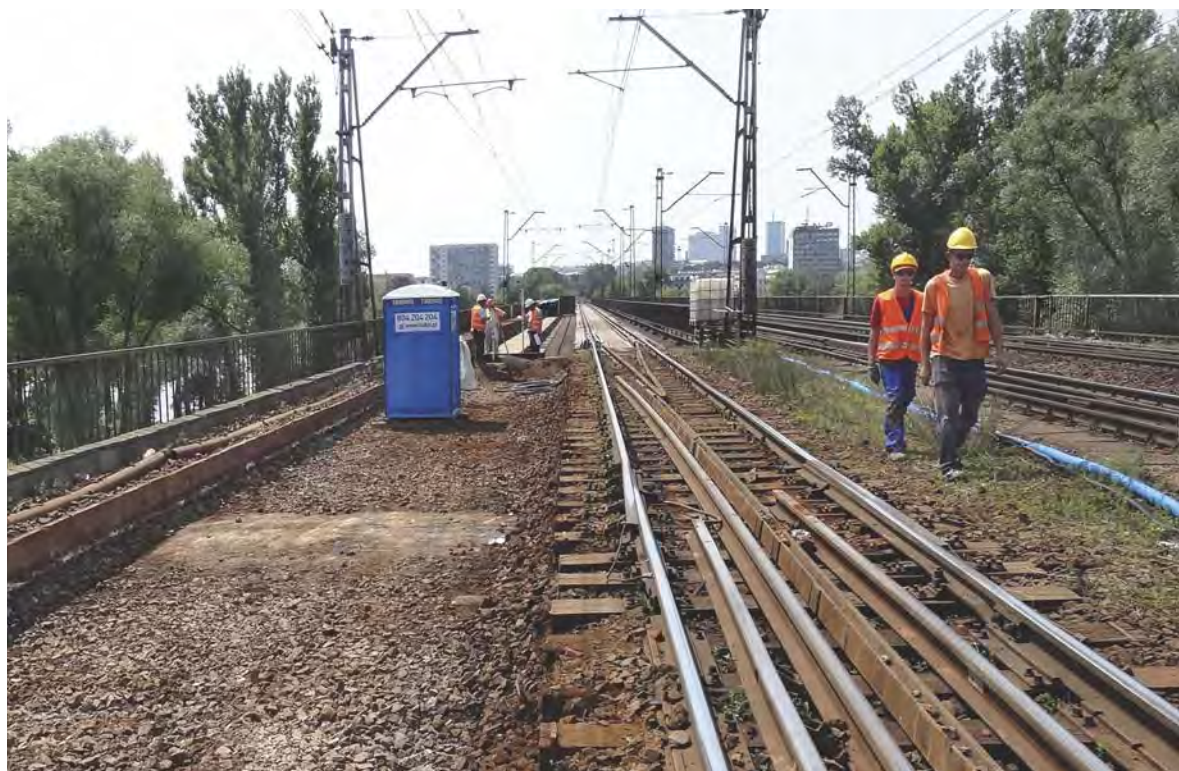
Fot. 5. Pracownicy, idący międzytorzem do miejsca robót
