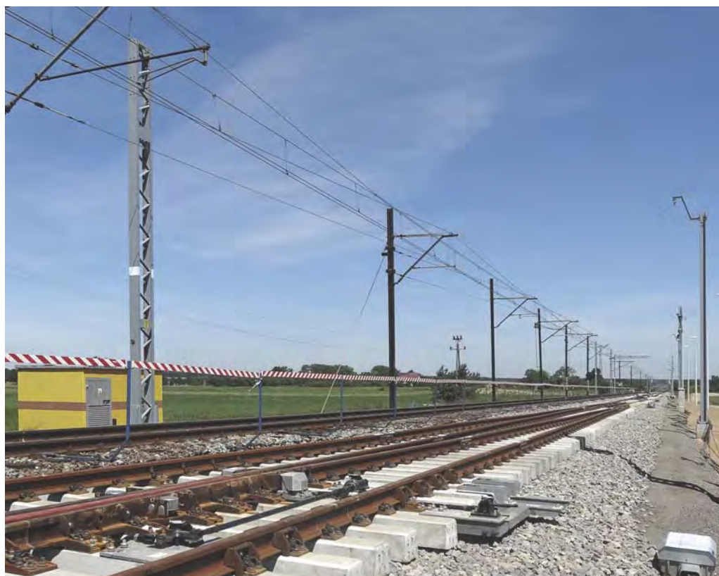
Fot. 27. Sieć trakcyjna na linii nr 4 Grodzisk Mazowiecki – Zawiercie – Centralna Magistrala Kolejowa
