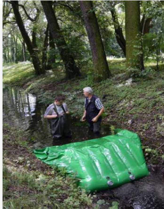
Przenośny próg piętrzący samoczynnie napęliający się wodą płynącą w rowie (źródło: Gospodarowanie wodą w rolnictwie w obliczu suszy, Ministerstwo Rolnictwa i Rozwoju Wsi, Warszawa 2020)
